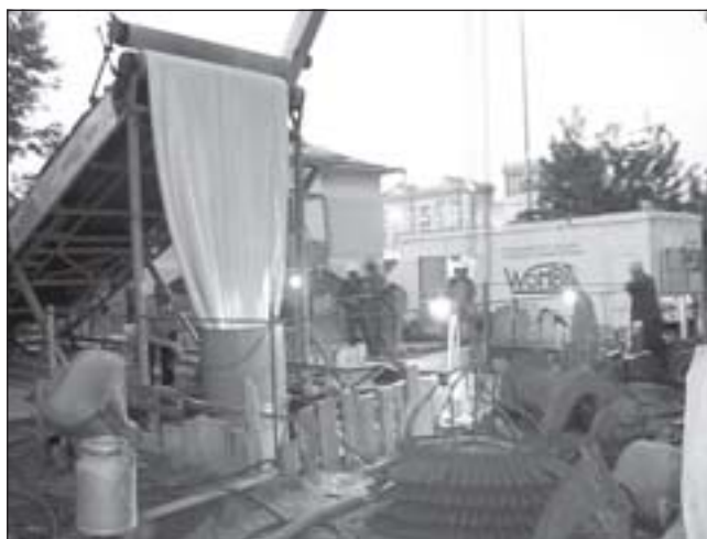
Sanace tlakového kanalizačního sběrače DN 1400 na Kutuzovském prospektu v Moskvě
