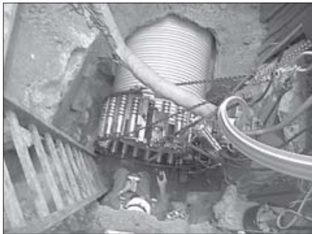
Skružovací hlava RIBLINE při sanaci
