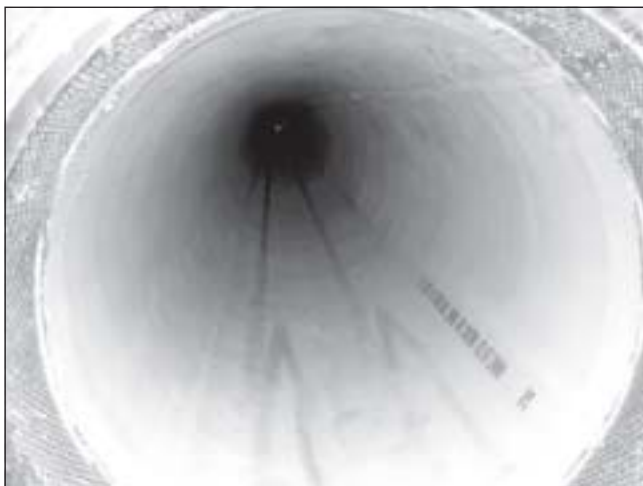
Obr. 5 – Pohled do sanovaného potrubí
