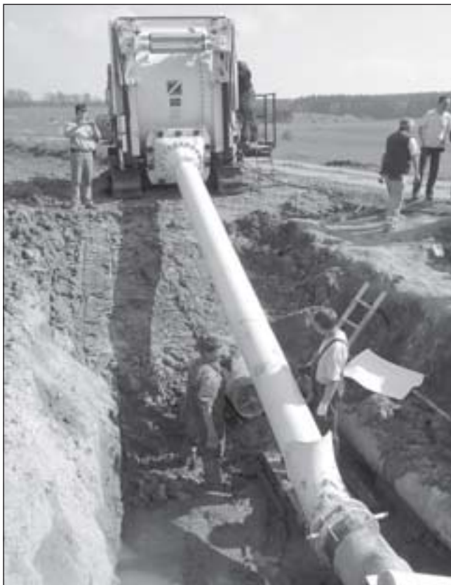
Obr. 4 – Proces reverzace sanačního rukávce do potrubí
