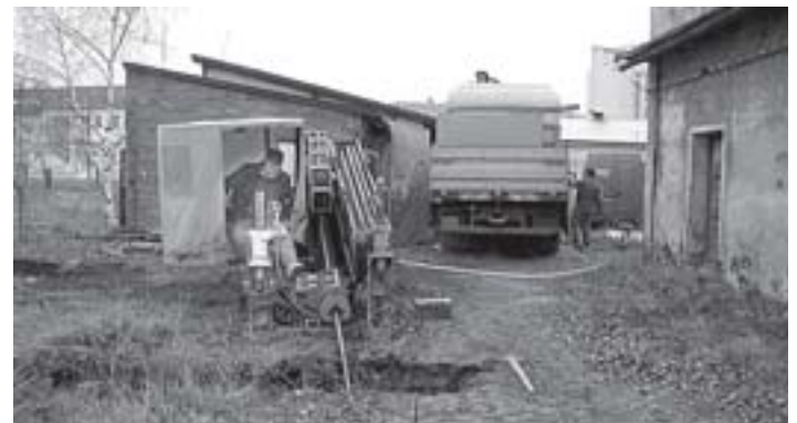
Stísněný prostor pro provedení pilotního vrtu soupravou VERMEER D24x33
