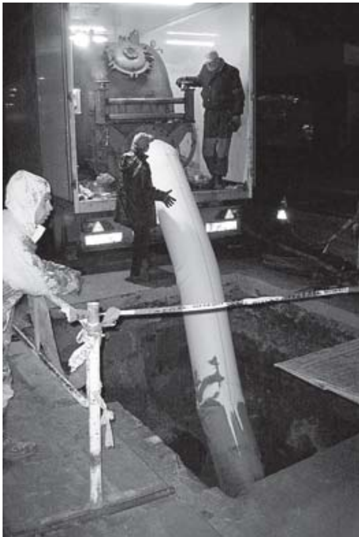
Počátek sanovaného úseku
