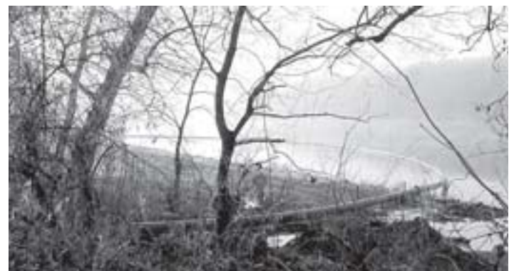
Při zatahování potrubí délky 208 m do vrtu musel být využíván i prostor na hladině řeky Labe
