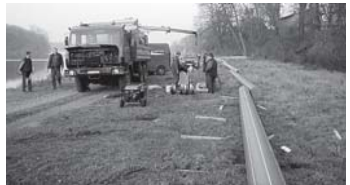
Svařování HDPE trub DN 315, PROFUSE SDR 17, PN 10
