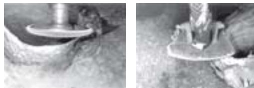
Oprava přesazených přípojek
