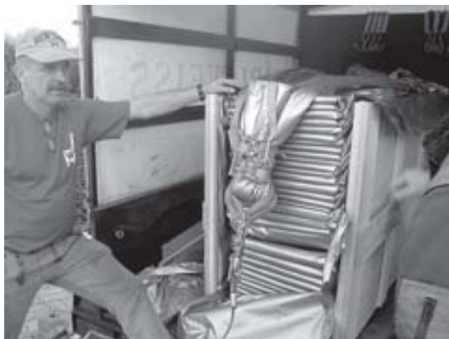
Obr. 2 – Sanační rukávec před zatažením do sanované stoky
