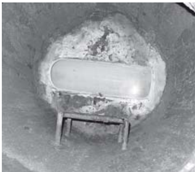
Obr. 2 – šachta po sanaci
