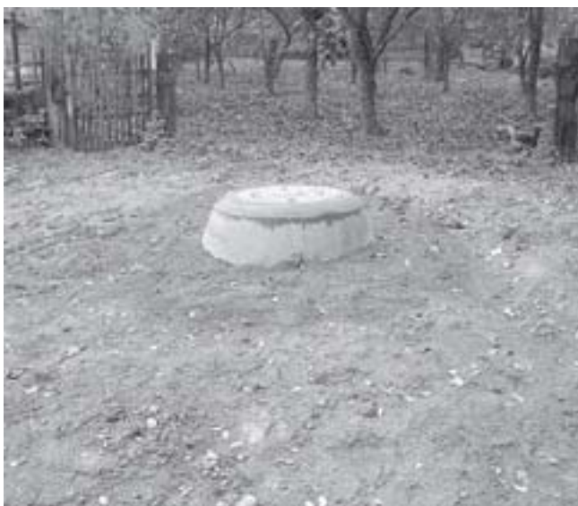
Obr. 3 – Kanalizační šachta v zahradě
