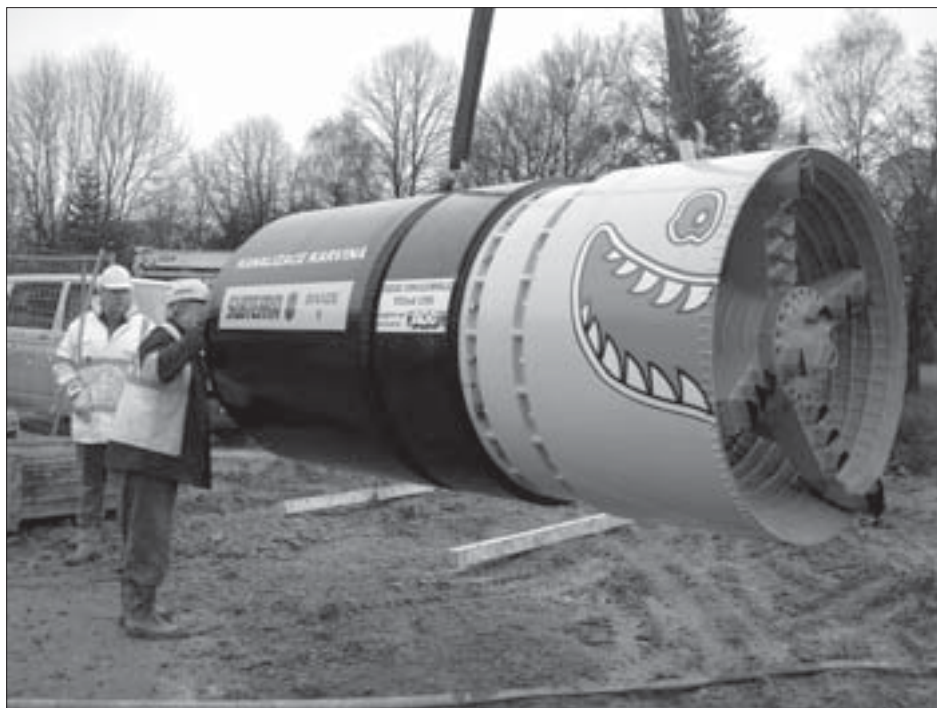
Spouštění mikrotunelovacího stroje Iseki TCC 1280
