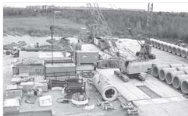
Celkový pohled na staveniště
