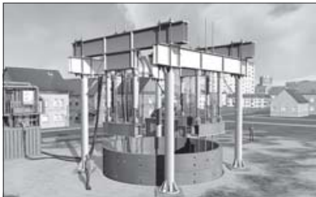
Svislé hloubení a spouštění šachty s použitím VSM – 5500/7700 systému
