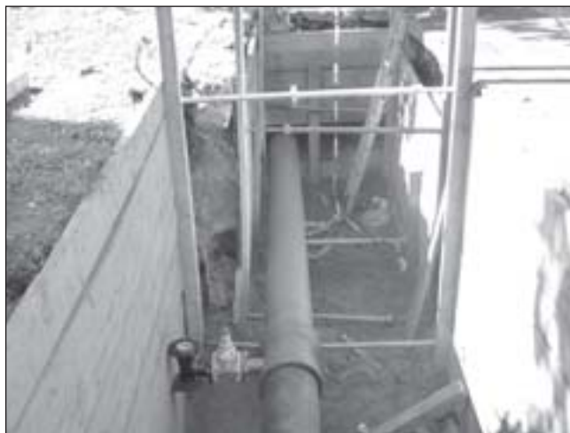
Pohled do trubní jámy po dokončení výměny
