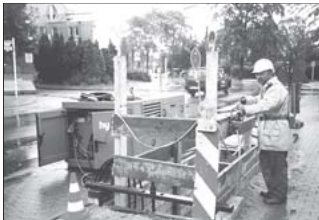
Staveniště metodou hydros®PLUS
